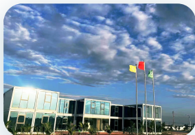
南沙物流配送及分拣 中心-办公楼
